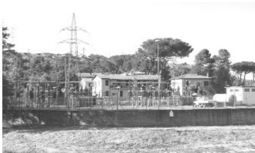
La centrale Idro-Elettrica di Castel Madama
